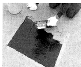
塗膜材の塗布例
